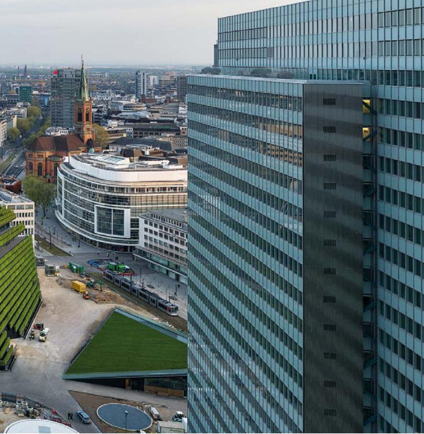
Die Konstruktion der Gebäudehülle basiert auf einem robusten System, das aus Stahl und Beton besteht und den notwendigen Halt für die Pflanzen und die dazugehörige Bewässerungstechnik bietet. Die Verwendung von Beton ermöglicht es, eine stabile und langlebige Basis zu schaffen, die sowohl die Last der Pflanzen als auch die zusätzlichen strukturellen Anforderungen durch das begrünte Dach und die Fassaden tragen kann.
